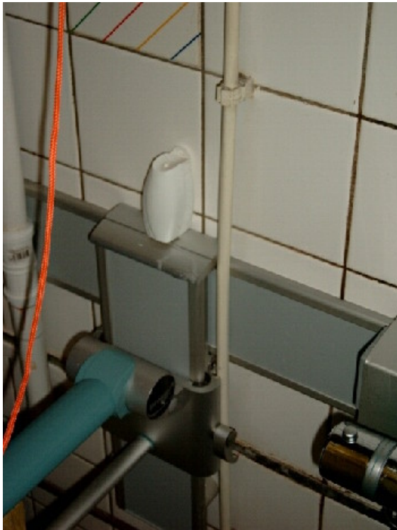
Foto 5.21 De bestaande leiding leverde uiteindelijk toch een barrière op voor het naar rechts verschuiven van deze steun. De gebruiker wilde de steun toch net iets verder naar rechts kunnen schuiven. De leiding werd omgelegd naar de leiding van de stortbak links op de foto.
