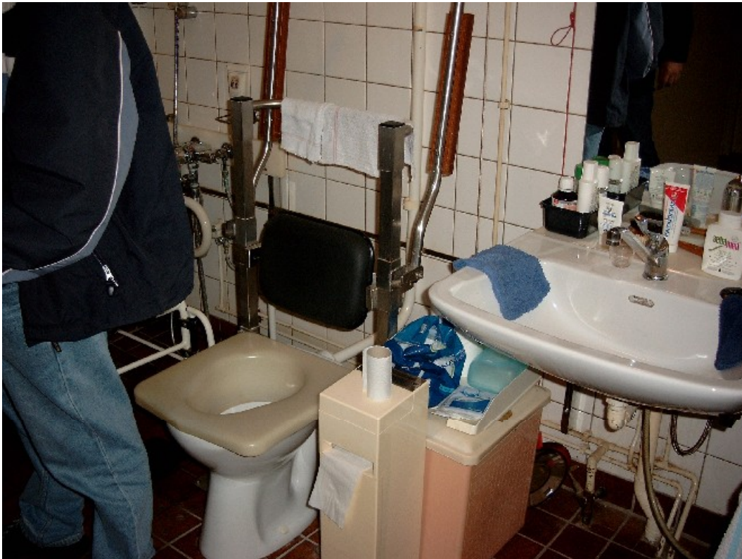
Foto 5.8. Foto van een natte cel in een aangepaste woning. Een voor rolstoelgebruikers aangepaste natte cel die echter knelpunten opleverde voor de zelfredzaamheid, autonomie van de gebruiker en fysieke belasting zorgverleners.
