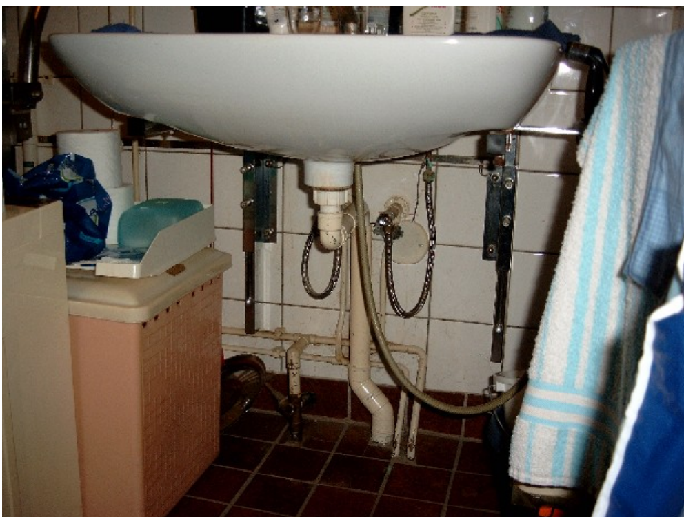
Foto 5.9. Foto van de problemen met de onderrijdbaarheid van wastafels voor personen in een rolstoel
