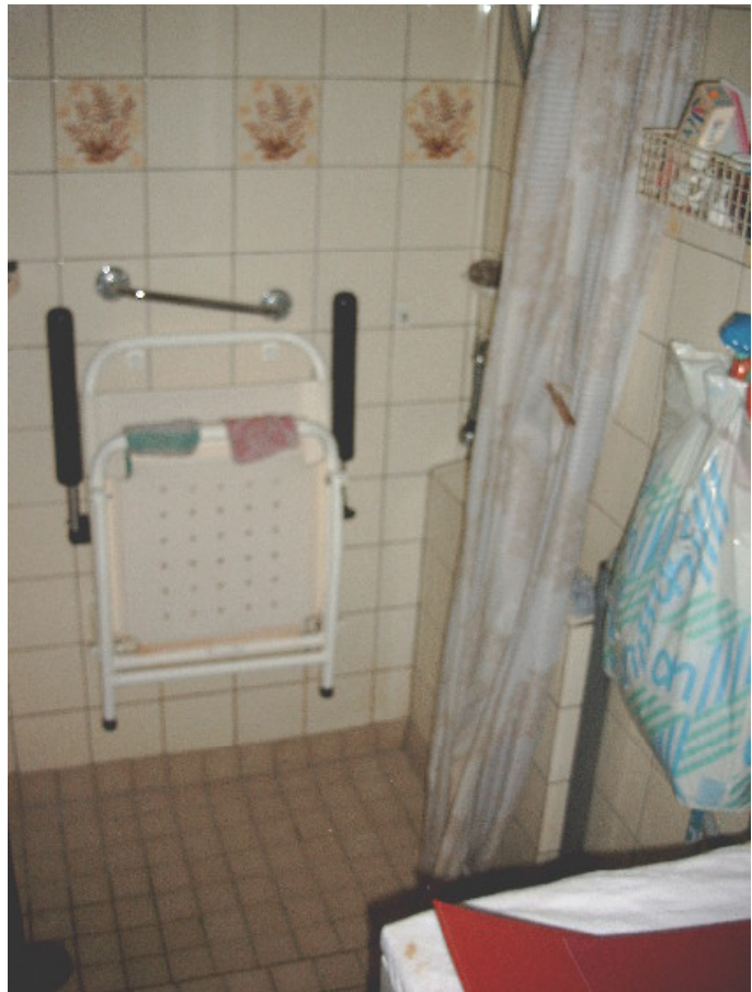
Foto 5.6. Een enigszins aangepaste douche in een nis. De situatie levert voor de zorgverlener en voor de gebruiker zelf veel problemen op qua fysieke belasting en qua valrisico
